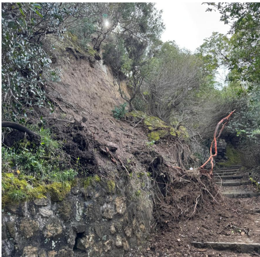
Fig.04 Frana che interessa il sentiero di accesso alla riserva
